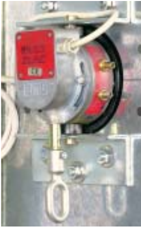
Moteur tubulaire avec anneau central.
