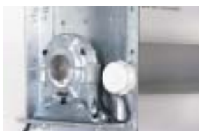
Parachute indépendant avec sécurité électrique
