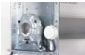
Parachute indépendant avec sécurité électrique
